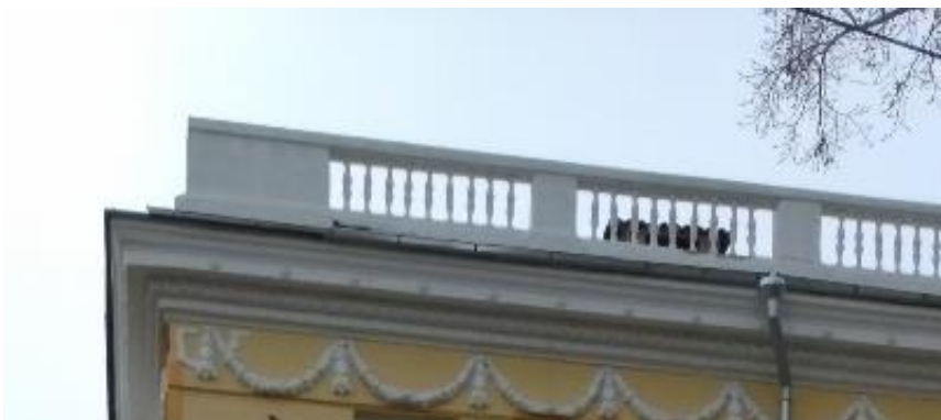
Рисунок 2 – Балясины и балюстрада (фото здания по ул. Победы)
