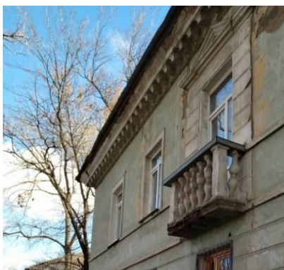
Рисунок 3 – Балясины и балюстрада (фото здания по ул. Победы)
