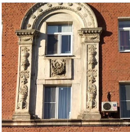
Рисунок 22 – Горельеф (фото здания по ул. Metallургов)
