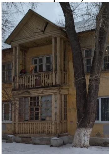
Рисунок 8 – Колоны (фото здания по ул. Кирова)
